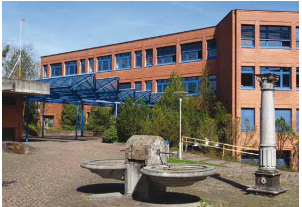
Hoher Finanzbedarf ausgewiesen: Die Renovation beim Schulhaus Röhrliberg 1
