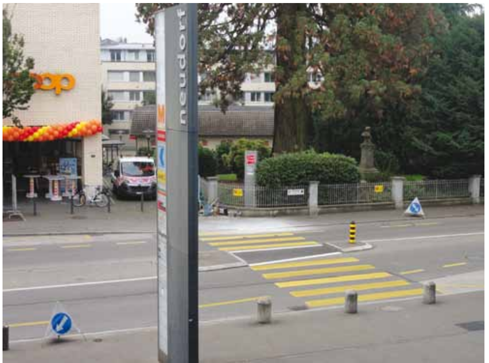
Der Fussgängerübergang Neudorf nun rollstuhlgängig
